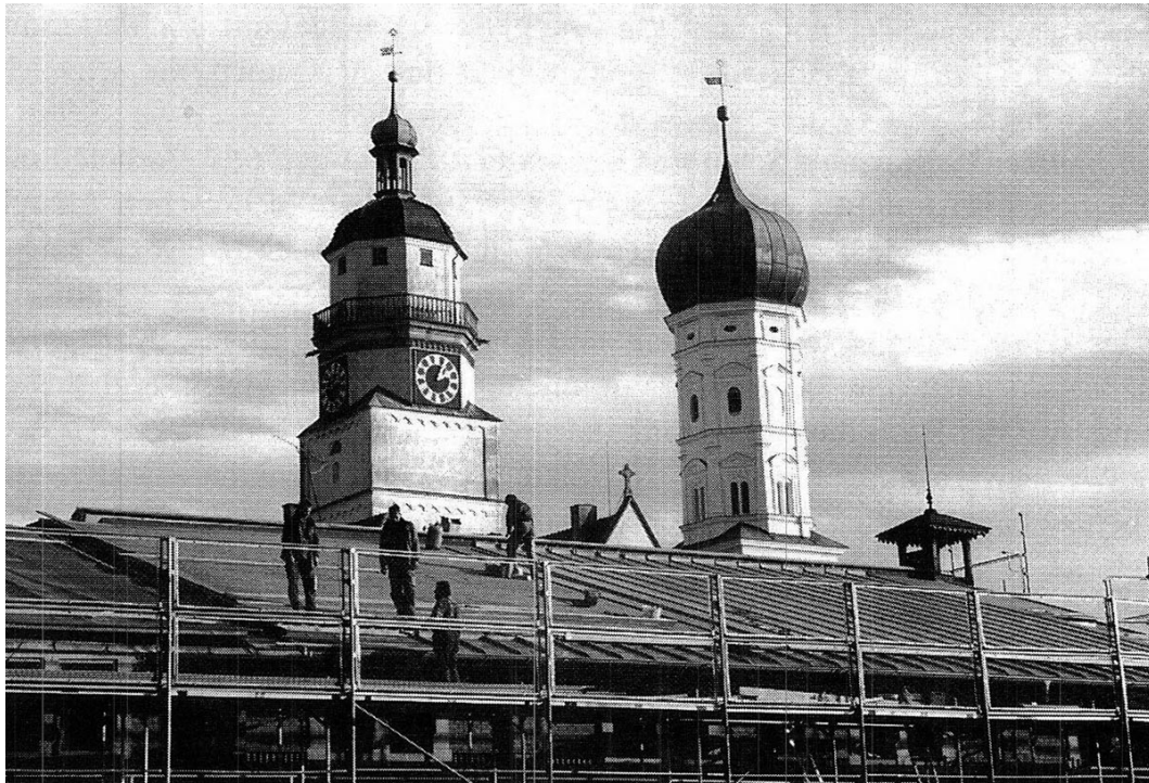
Abb. 7: Sanierungsarbeiten am Dach 1994. Sammlung Wolfgang Heger.
