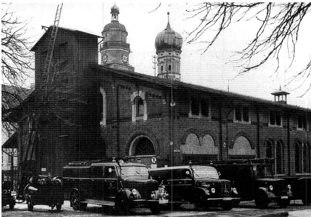
Abb. 6: Feuerwehrdepot 1962 mit Turmanbau als Steigerturm für Übungszwecke und zum Trocknen der Schläuche. Sammlung Helene Nieß.
