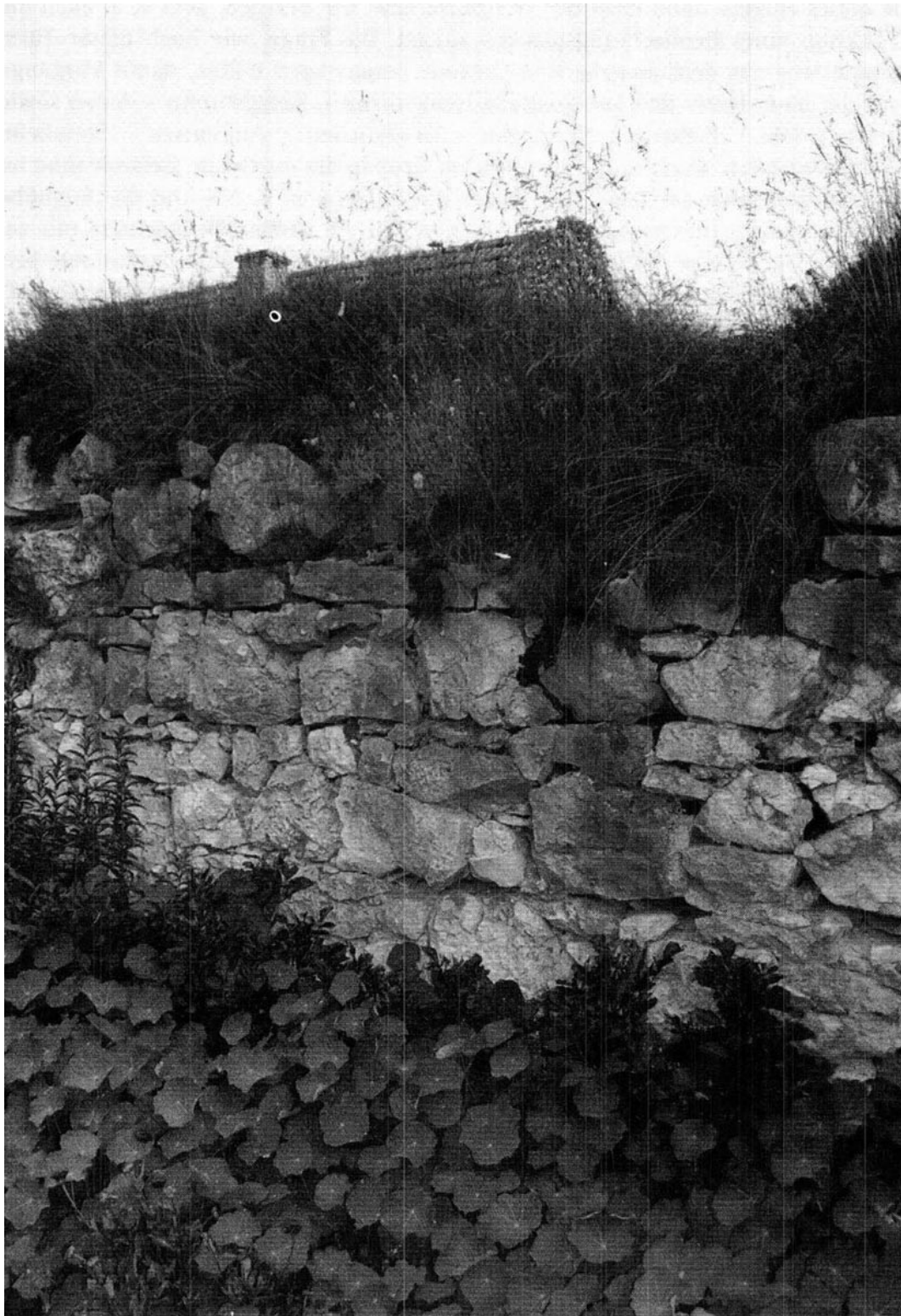
Abb. 4: Schloßmauer, von Süden gesehen.
