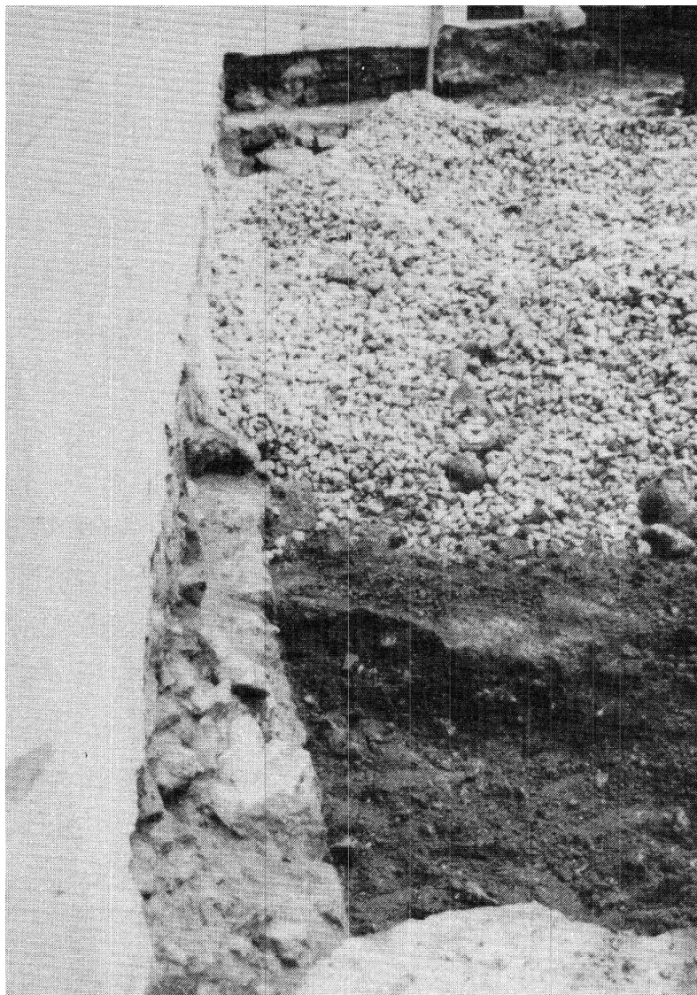
Abb. 2: Mauer entlang der Ost-Mauer des Innenhofes.
