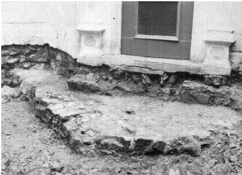
Abb. 4: Fundamentplateau unter dem Treppenturm.
