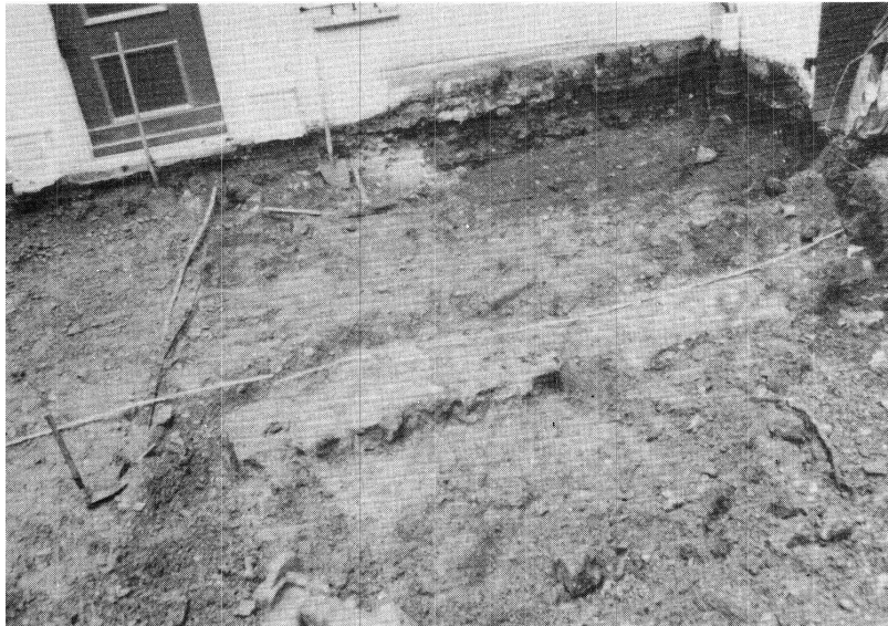
Abb. 5: Mauer in West-Ost-Richtung im Innenhof.
