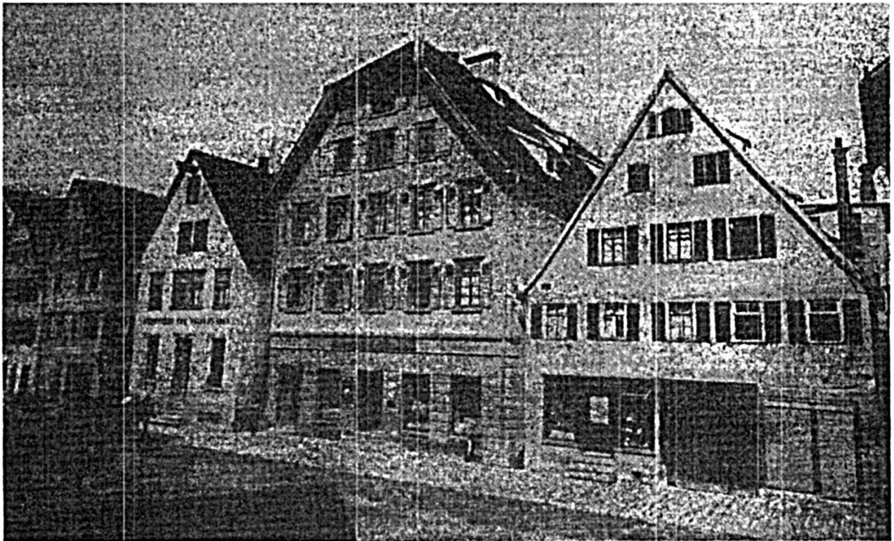
Abb. 3: Von links nach rechts: Gebäude Nr. 22, Nr. 23 (Weißes Röble), Nr. 24 (Gebr. Schaefer) und Nr. 25 von Südwesten um 1896 (Aus: Der hellenstein Bd. 6, 1961, S. 126)
