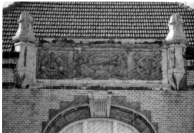
Abb. 11: WCM, Maschinenbaus, Detail der Ostfassade (1903/04).
