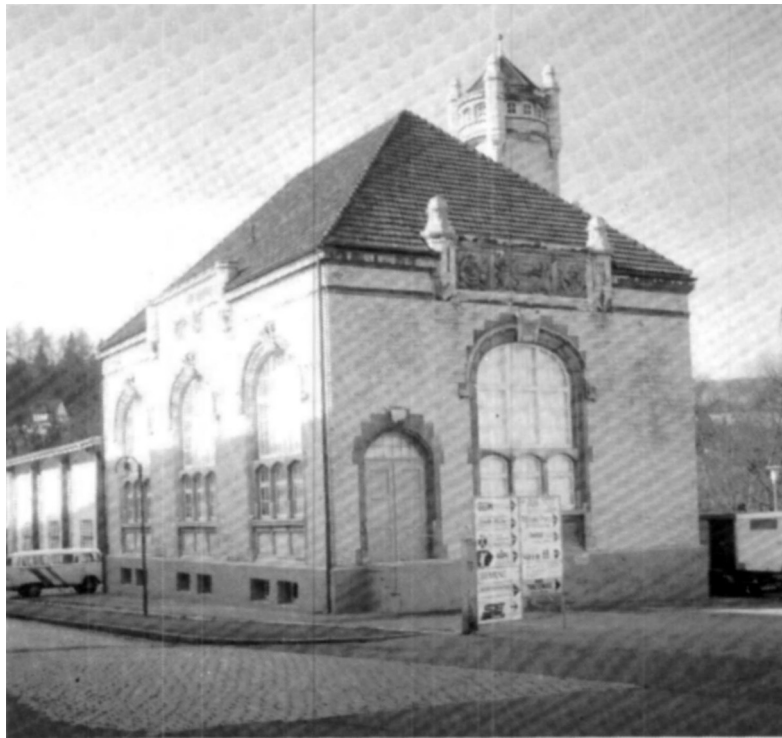
Abb. 6: WCM, Maschinenhaus (1903/04), Ansicht von Osten.
