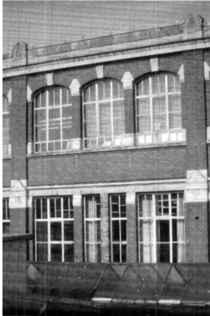
Abb. 12: WCM, Gravüre (1904/05), Detail der Südfassade.
