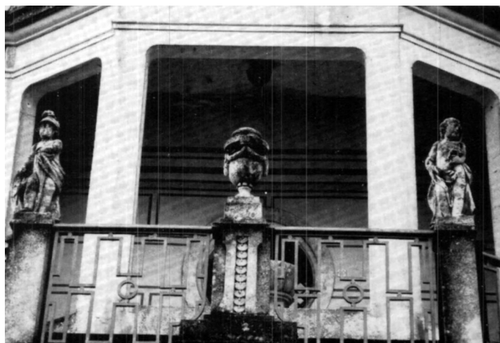
Abb. 6: Geländerabschnitt über dem Portalvorbau
