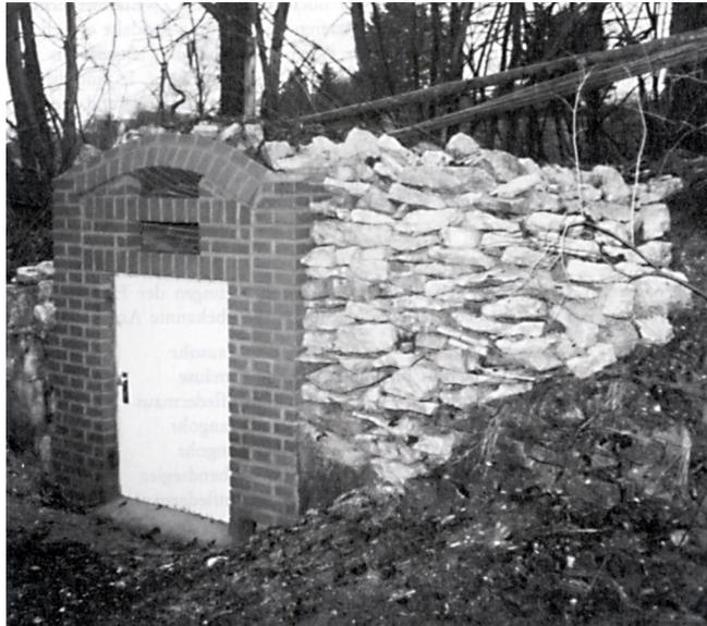
Abb. 4: Keller bei Küpfendorf. Der neu ins bestehende Trockenmauerwerk eingebaute Eingang weist im oberen Teil zwei Fledermaus-Fluglöcher und im unteren Teil ein Amphibienschlupfloch auf. Foto: Schäffler.
