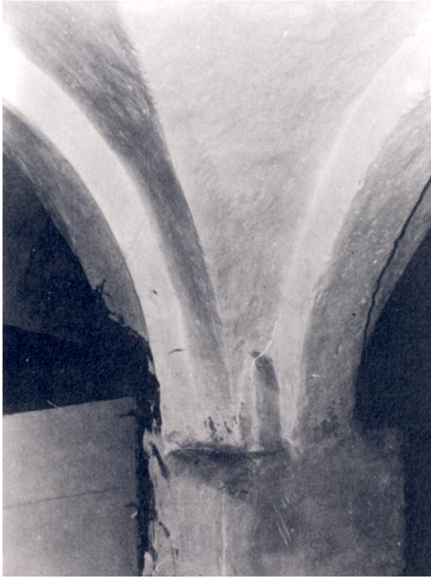
Abb. 6: Karolingisches Kreuzrippengewölbe im Kellergeschoß des Klosters
