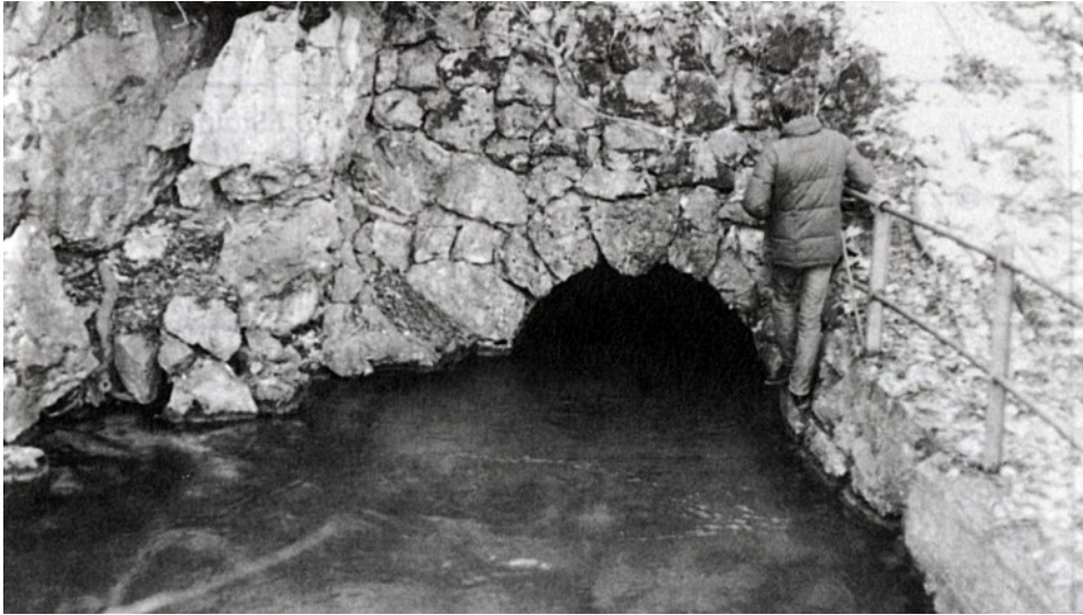
Abb. 2: Die Brunnenmühlquelle im Werksgelände der Firma Voith ist eine der größten Karstquellen des Brenztals.
