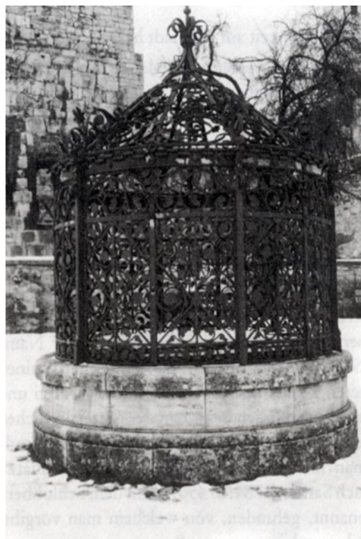
Abb. 4: Der Schloßbrunnen auf Schloß Hellenstein ist mit einer historischen Gitterkonstruktion gesichert.
